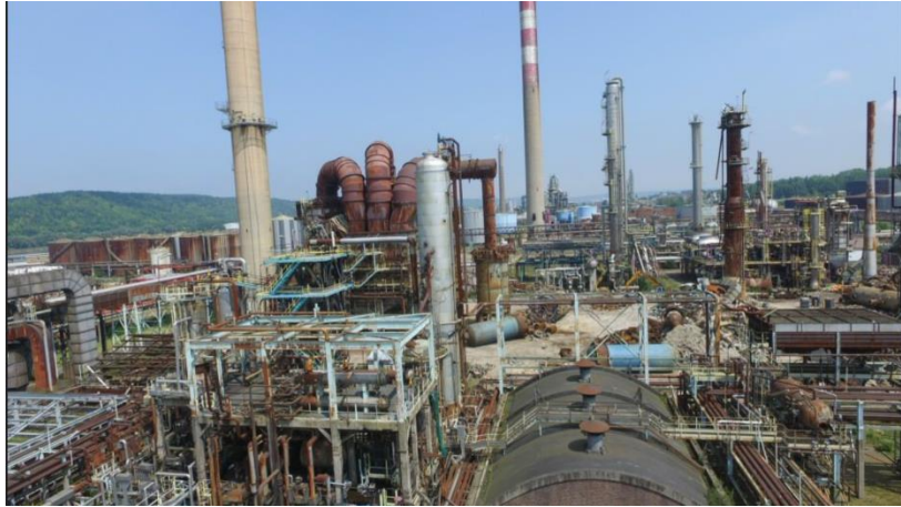
Figure 3 : la raffinerie à l'arrêt, vue aérienne de 2015
